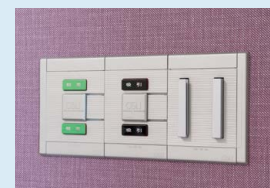
バイキング設備 酸素・吸引のバイキング設備も完備しています。
